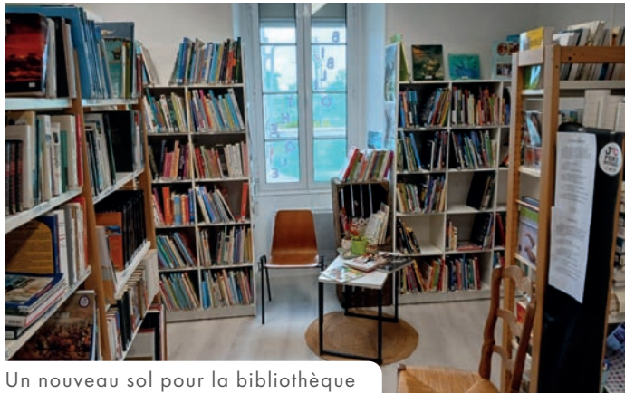
Un nouveau sol pour la bibliothèque
